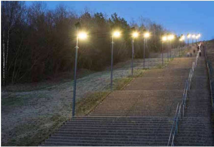
protos Treppe Wilhelmberg / NL
